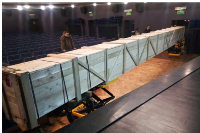
Montaż nowego ekranu
