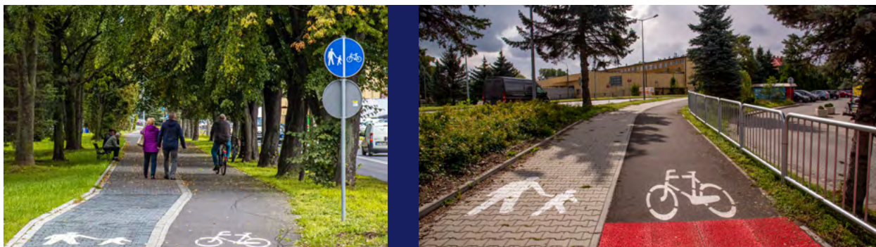
Ciąg pieszo-rowerowy, ul. Putka
